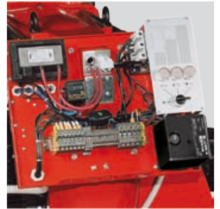
P140 - 00 - 300 - 450T/N(ECO)型燃烧器接线端子板电气连接示例
